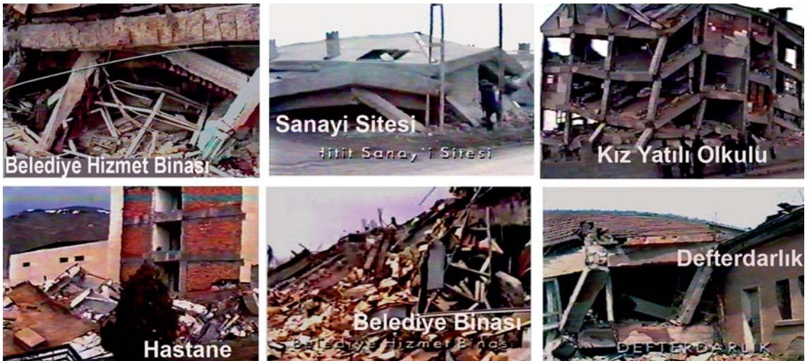
Şekil 7 - Erzincan'da 1992 depreminde yıkılan önemli binalardan bazıları [4]
