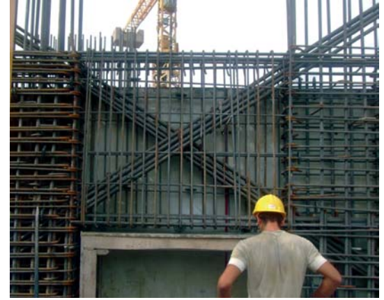
Resim 7 - Kule B: Bağ kirişi donatısı
