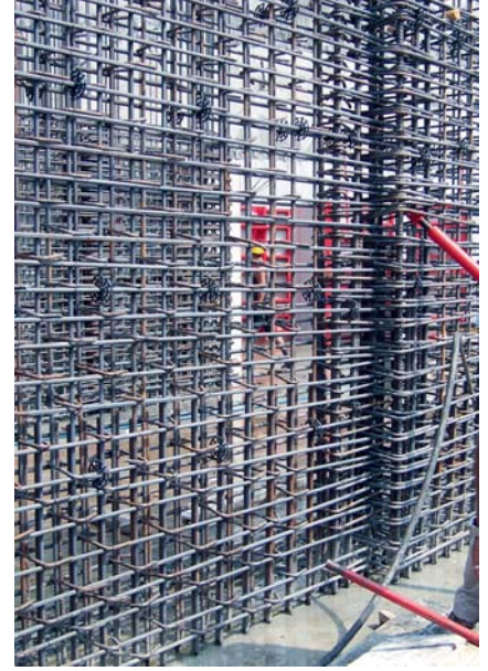
Resim 6 - Kule B: Tipik perde duvar donatısı
