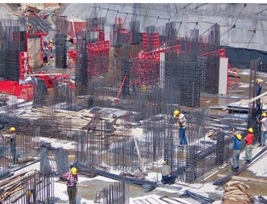
Resim 5 - Üst yapı çalışmalarından genel görünüm
