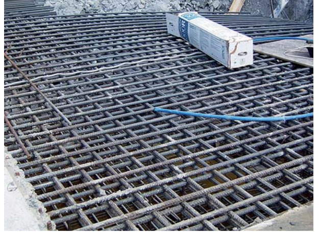
Resim 4 - Temel üst donatılarının görünümü
