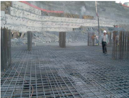
Resim 8 - Kule B: Döşeme donatısı
