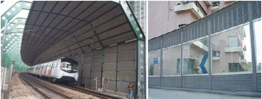
Şekil 10 - Solda çelik karkası olan bir ses perdesi ve sağda konut bölgesinde yapılan bir çalışma görülmektedir.
