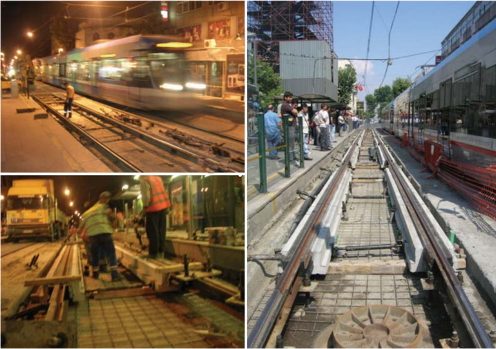
Şekil 7 - İstanbul Tarihi yarımada da Unesco dünya miras listesinde yer alan Çemberlitaş Bizans kolonu sürekli kiriş sistemi ile sönümlenmiştir. Yaklaşık 1500 yıllık Bizans kolonuna 5 m uzaktaki hattan gelen tüm zararlı etkiler minimize edilmiş ve üst kaplama asfalt seçilmiştir. Prefabrik kirişlerin içinde özel kauçuk kapsülasyon bulunmaktadır.
