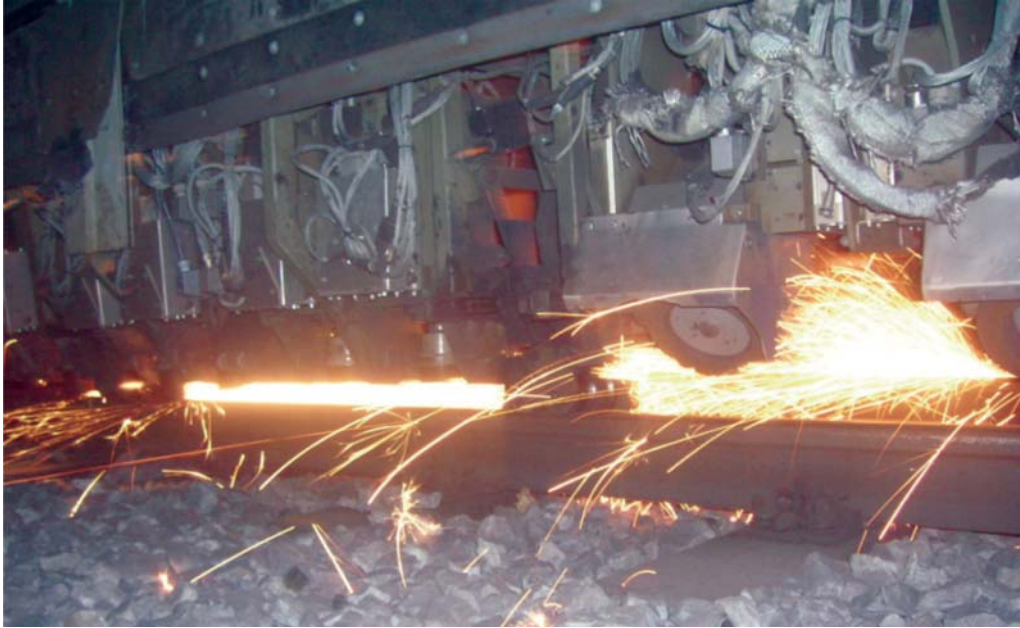
Şekil 1 - Rayın aynı anda 10 farklı noktası taşlanıyor
